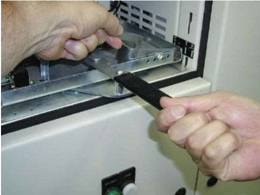
Lắp ngăn rút kéo Mw của tủ điện Blokset Blokset type Mw Drawer insertion
